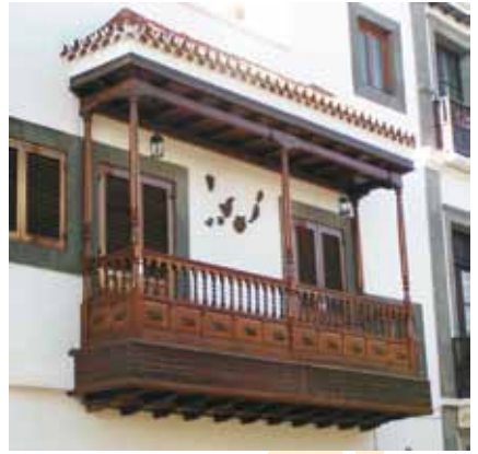
Imágenes de los balcones de Moya
